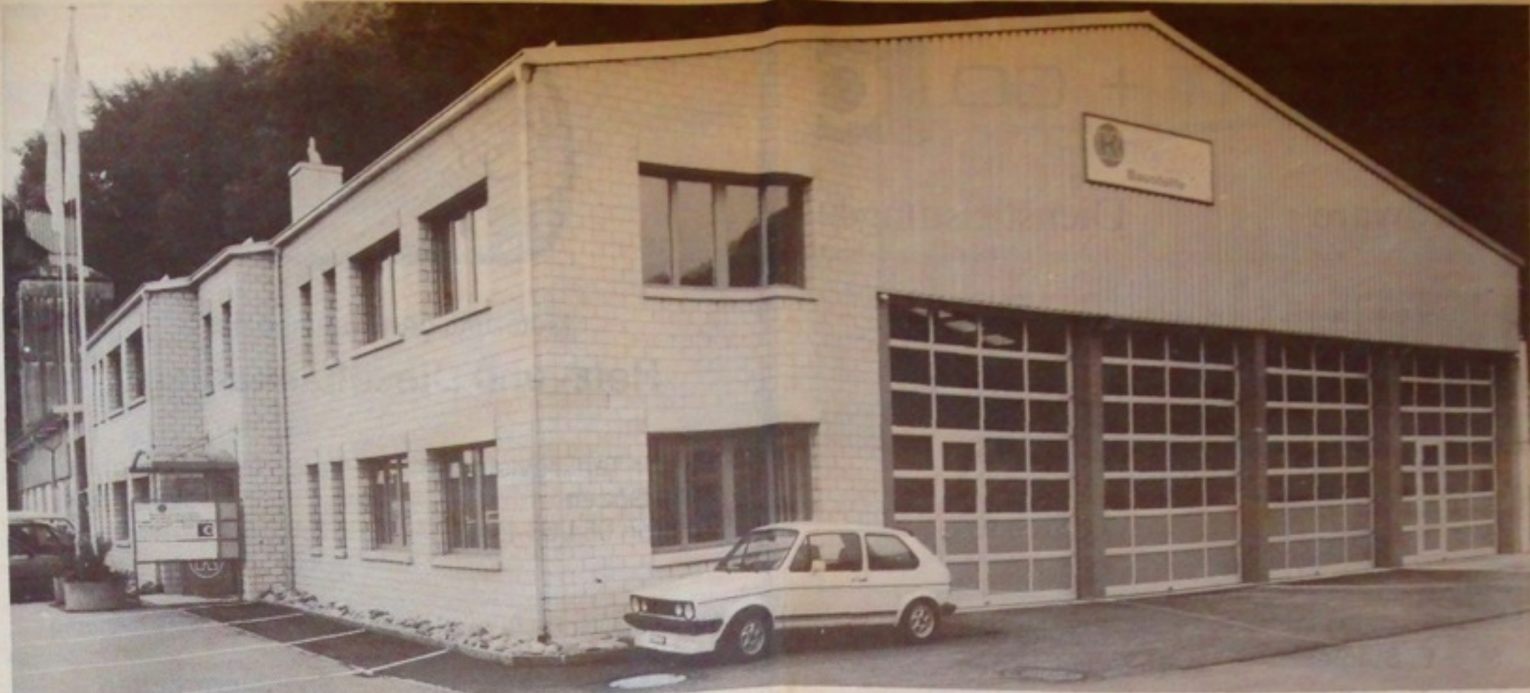
Der Hallen-Neubau, der am kommenden Wochenende eingeweiht wird.
