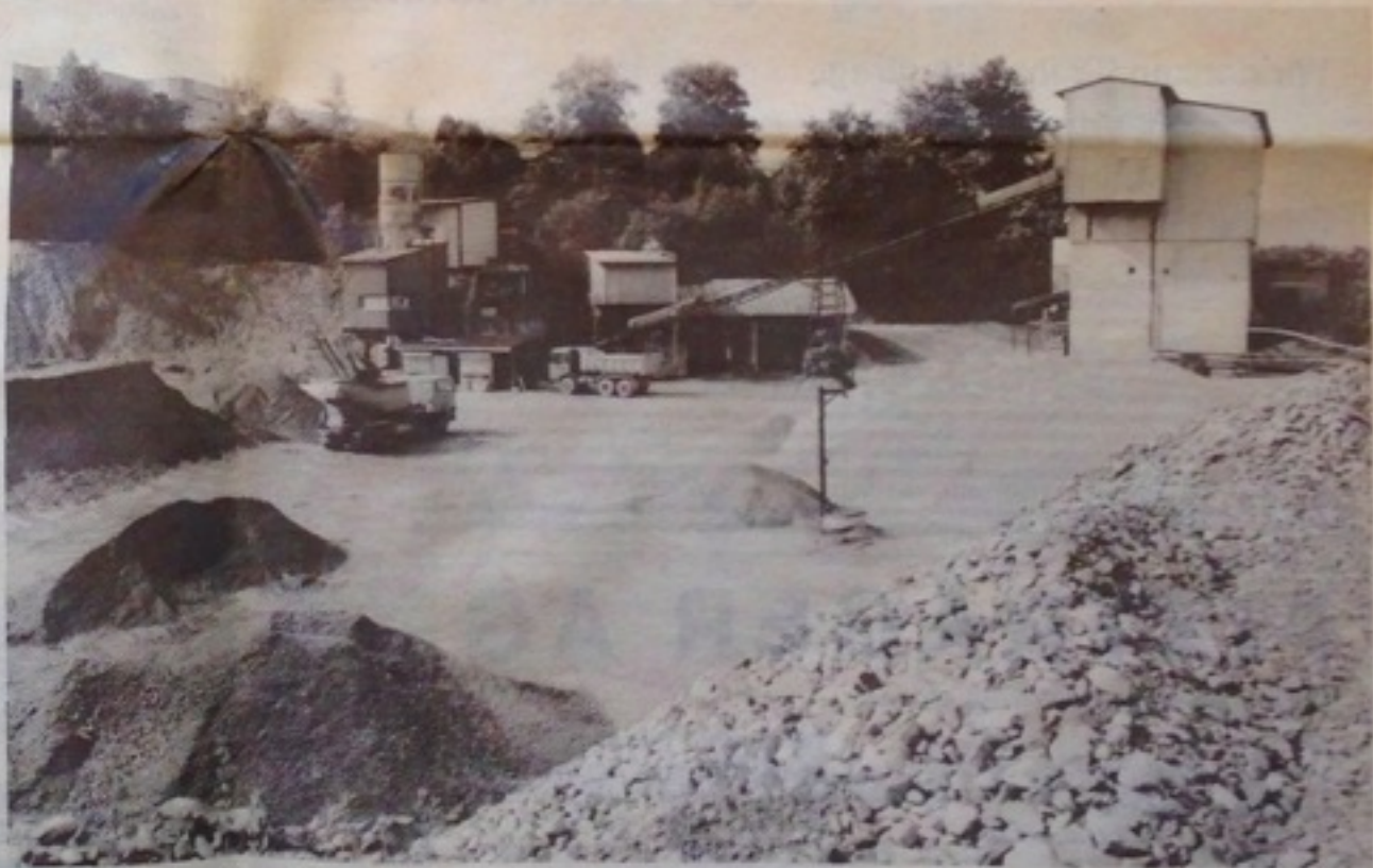
Das Kieswerk der Knecht GmbH in Etzgen.
